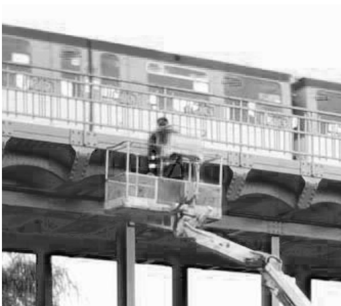
Abbildung 7: Einsatzort bei einer Bauwerksprüfung
