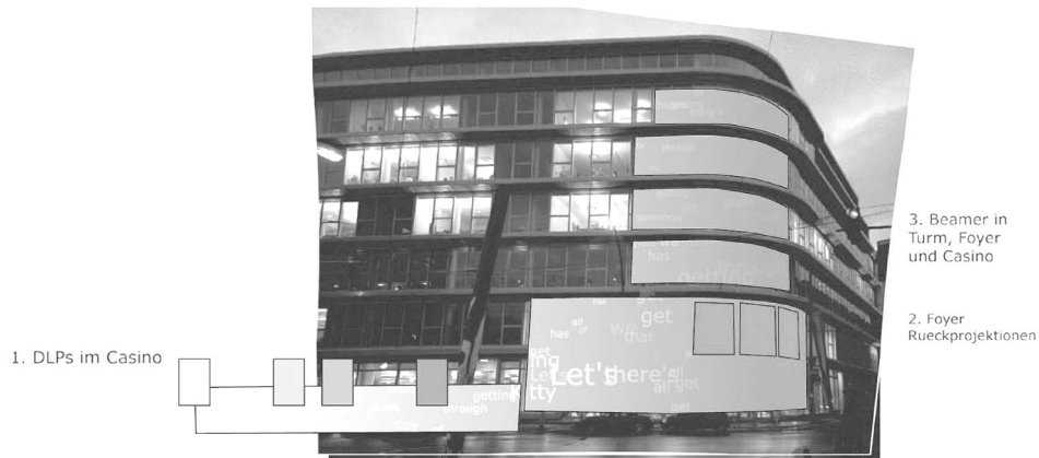
Abbildung 1: Ansicht der Medienfassade in der Rosenthaler Straße
