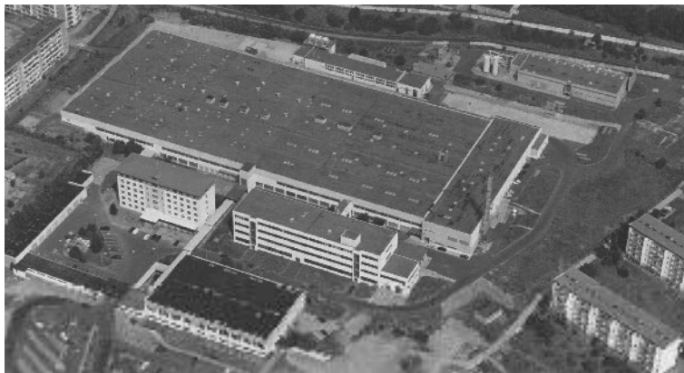
Abbildung 17: Die Reinraumfabrik in Meiningen (90 m x 240 m)
